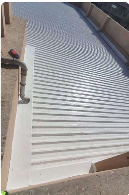
Membrane at roof edge
