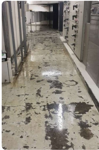
2. Application of primer
